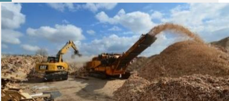
© Ramery Environnement (broyage du bois issu des encombrants)
